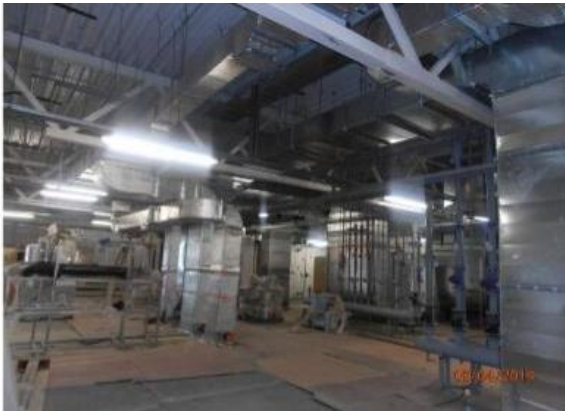
Прокладка внутренних инженерных систем
